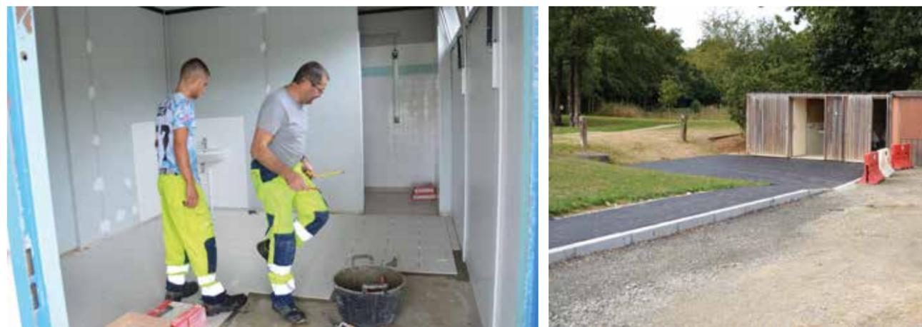
**Vestiaires foot de Saint-Aubin du Pavail :** Rénovation complète d'un vestiaire du stade, remplacement des sanitaires, de la faïence et du carrelage, remplacement des bancs...
