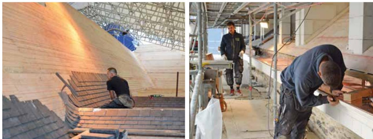
**Château :** Poursuite de la seconde tranche des travaux de restauration des fenêtres et de la toiture. Actuellement : couverture et pose de zinguerie, gouttières.
