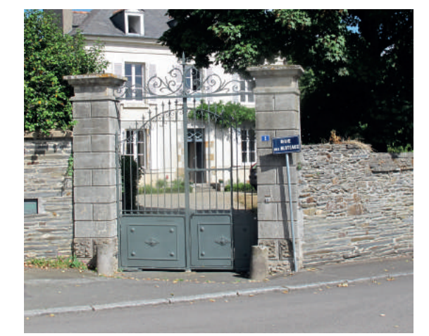
7. MUR DE CLOTURE REMARQUABLE PORTAIL REMARQUABLE
